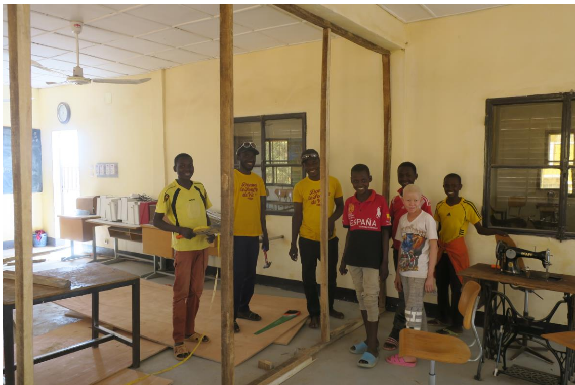
Installationsarbeiten eines Labors für die Mittelschüler des Zentrums
